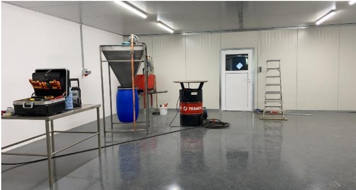
Abbildung 15: Bauarbeiten zum Aufbau erweiterter Räumlichkeiten für die Produktveredelung (Pulververmahlung, Abfüllung, Extraktion) und Zwischenlagerung am Hauptsitz der Agrinova Projektmanagement GmbH in Langförden.
