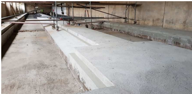
Abbildung 15: Anschrägung des Gangbereiches beim Umbau der Abferkelabteile
