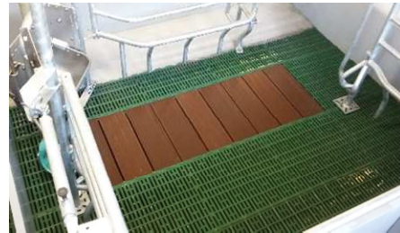
Keramik/Keramik und PVC Die 3 hinteren Platten wurden aufgrund hochgradiger Verschmutzung der Liegeflächen durch PVC Rosten ersetzt
