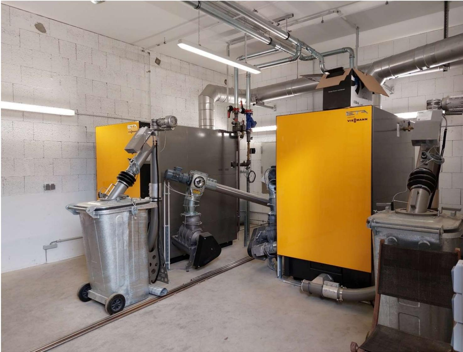
2022 Bau und Inbetriebnahme Nahwärmenetz in Marienthal, Kesselanlage: Pelletkessel 180 KW und 240 KW
