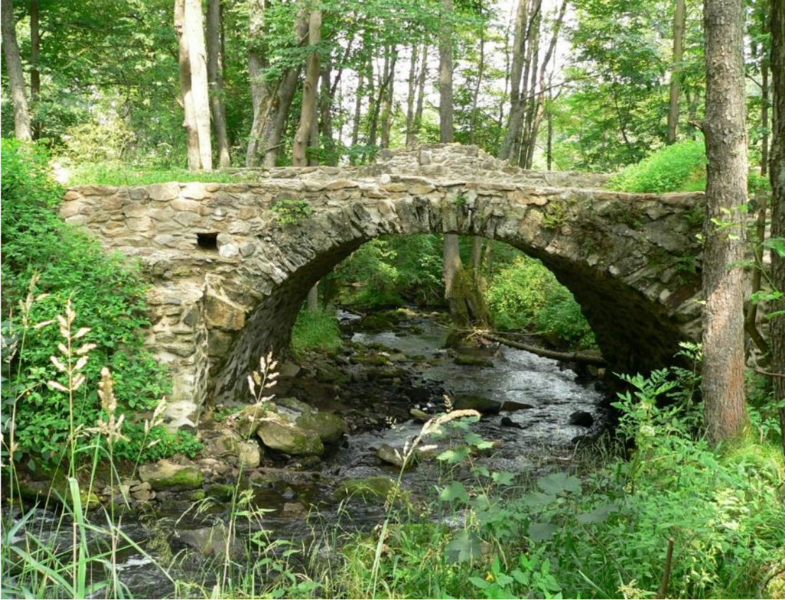
Brücke des ehem. Ortes Mostek ( Schwänenbrückl )
