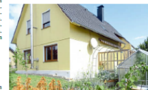
Val Arbeit: Das Haus der Familie wurde umfassend renoviert. Zudem sind ein Ober- und Gartengewässer entstanden. Foto: reuter
