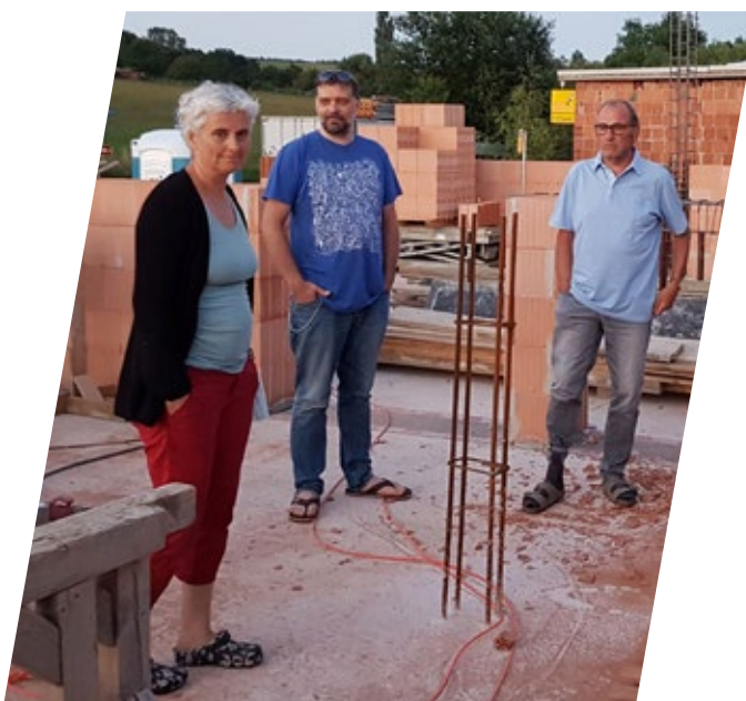
Hier soll der Dorfladen entstehen: Besichtigung der Baustelle.
